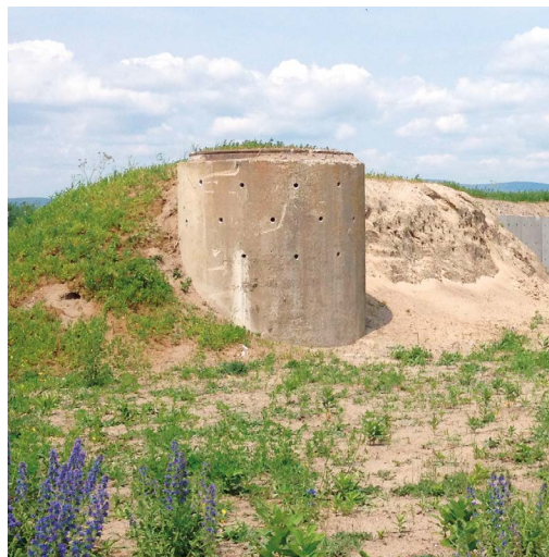
Conduites de béton verticales prépercées
