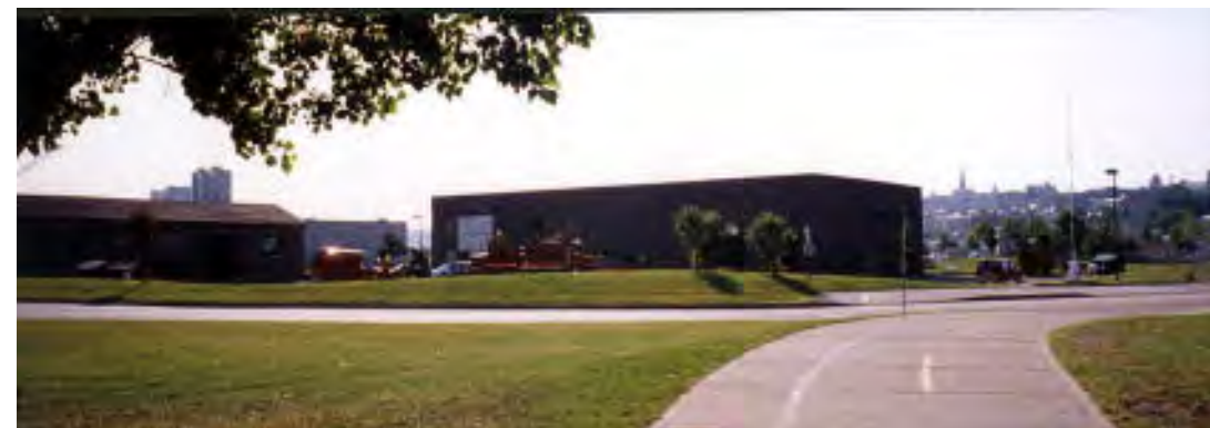
Photo 11 : Ateliers de l'APQ, rue de l'Estuaire, vus de la piste cyclable.
