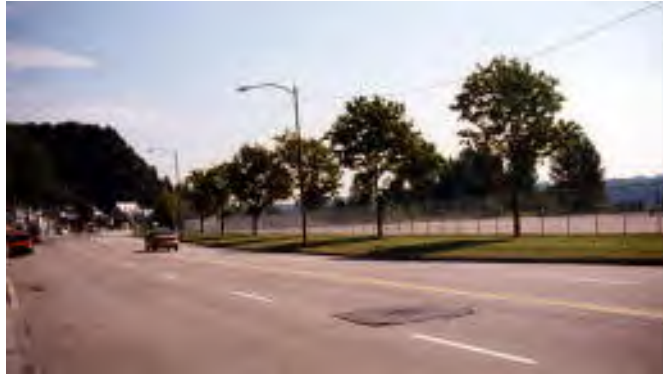
Photo 1 : Traitement paysager en bordure du boulevard Champlain.
