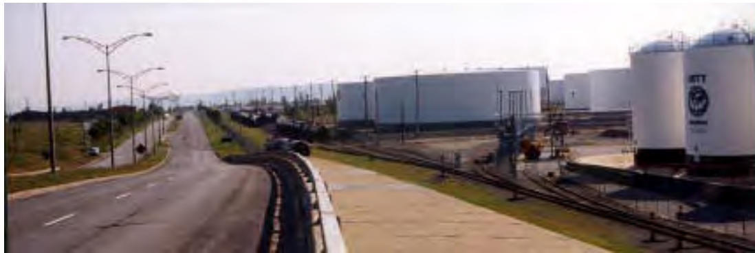
Photo 2 : Perspective du boulevard Henri-Bourassa sur l'intérieur du site portuaire.
