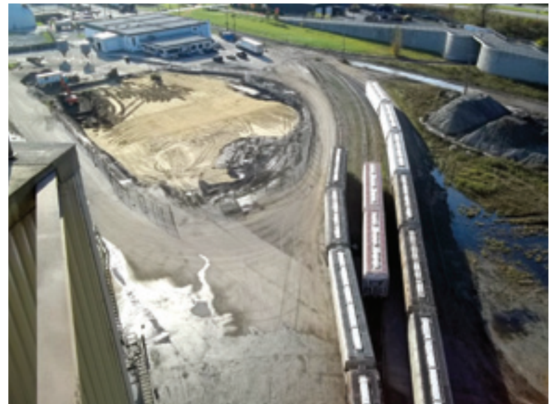
Décontamination du sol dans le cadre de la construction d'un nouveau bâtiment par La Coop Fédérée dans le secteur du Foulon
